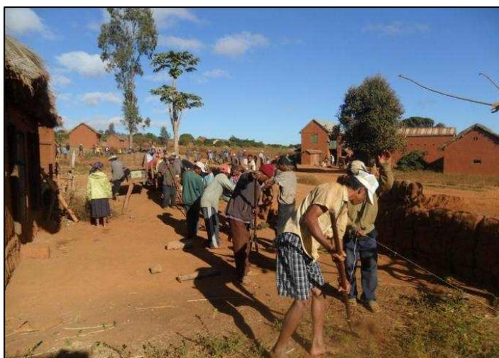
Travaux de creuse pour installer les amenées d'eau de la nouvelle borne fontaine
